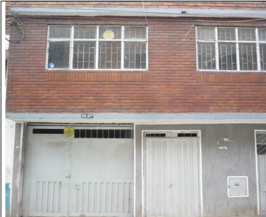
Foto No. 1 Fachada del establecimiento
